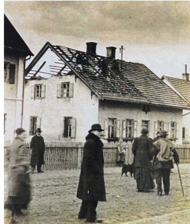
30. April 1919: Dieses nach Artilleriebeschuss beschädigte Haus stand an der Brucker Straße.
